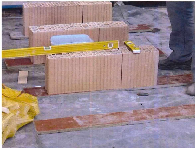
Photo 2 : première couche de pierres posées à niveau, les unes à côté des autres, sur la planche
