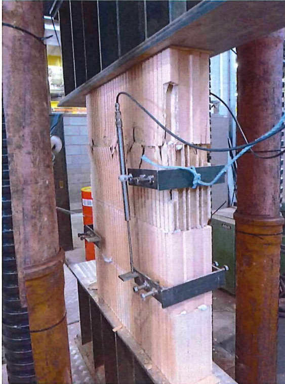
Photo 11 : Mur D4 après rupture
