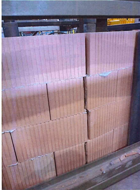
Photo 10 : BH4 après rupture
